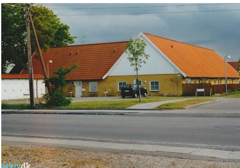
(B794) 1998 – efter ombygningen
