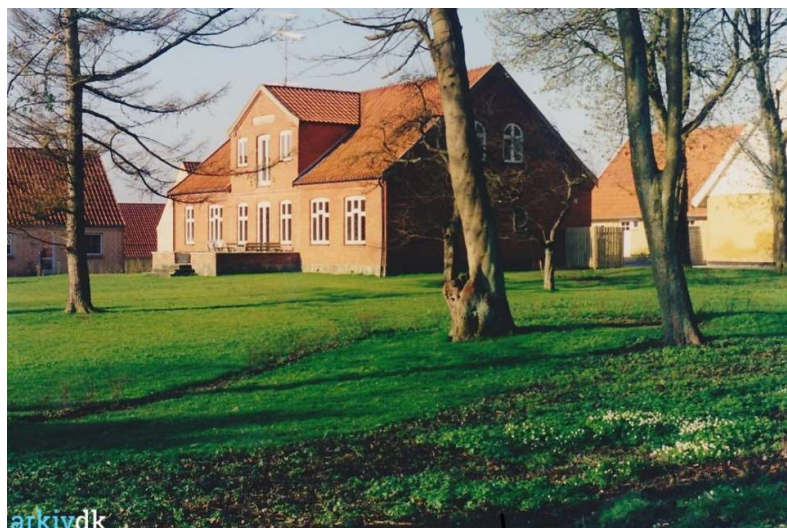
(B794) Stuehuset efter ombygningen 1998
