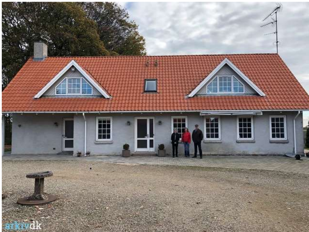
2018: Lotte og Brian sammen med Pia Jacobsen foran det renoverede stuehus.
