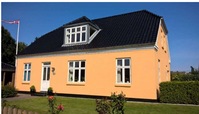
Kærvej 19, det hus, som M.C. Hansen opførte 1913-17, og som blev bolig for mejeriejer Peter Jensen.
