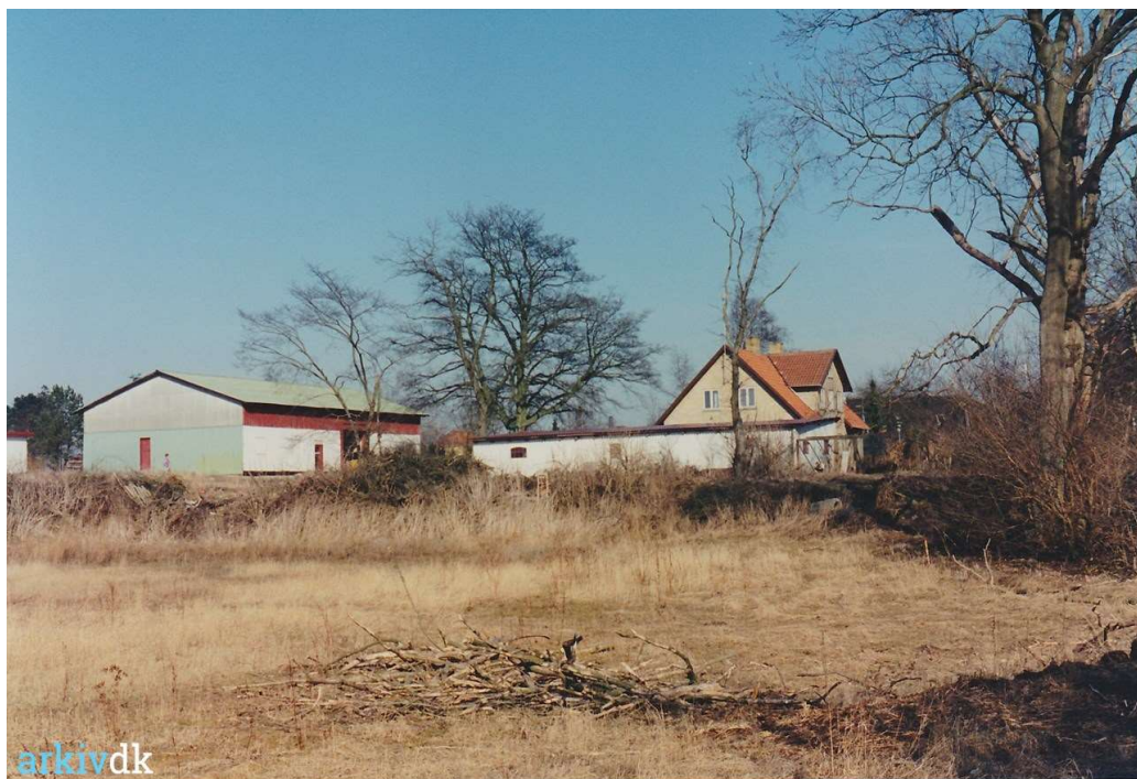
Stålmosegård 1996 set fra vest med lade, "svinehus" og stuehus fra krigens sidste år.
